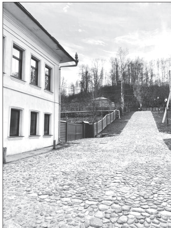
Реконструкция переулка - первый опыт восстановления булыжных мостовых
